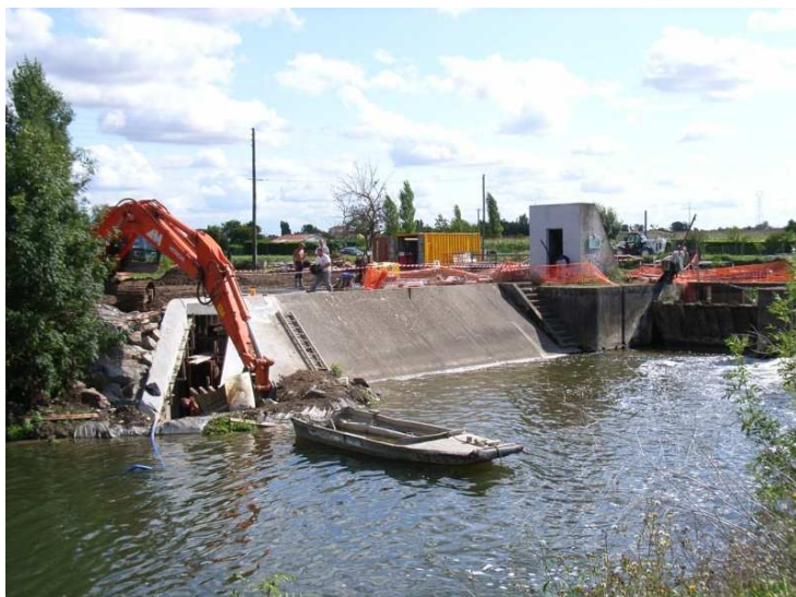
Passe à poissons toutes espèces du Marais Pin, Magné - 79 - (FEOGA 2006)
