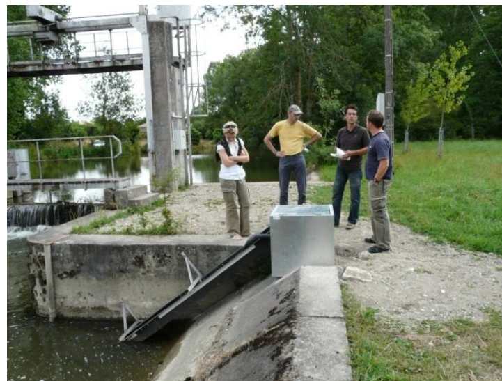
Passe à anguilles – barrage de l'Ouchette, Magné - 79 (FEADER 2008)
